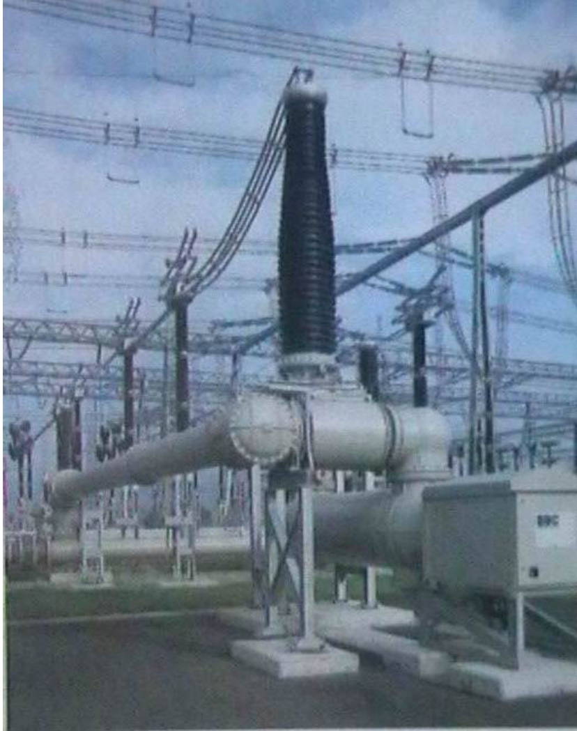
شکل ۵-۱ شینه تک فاز در داخل محفظه بسته گاز ورودی یا بوشینگ محفظه
